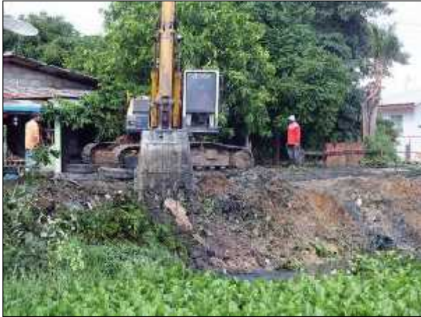
ภาพ : โครงการจ้างเหมารถแบ็คโฮขุดลอกคลอง กำจัดวัชพืช
